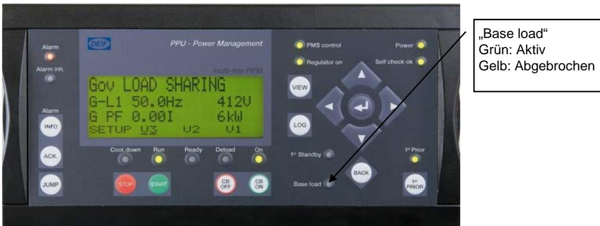
Die asymmetrische Lastverteilung ist *nur* aktiv, wenn zwei oder mehrere Generatoren parallel in Betrieb sind und sich in der Betriebsart AUTO (Automatikbetrieb) befinden. Die Grundlast wird von dem Generator mit der ersten Priorität erzeugt, die der Bediener festgelegt hat.
