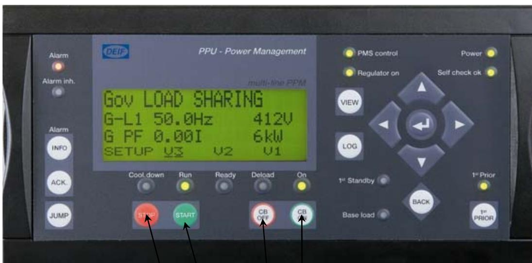
CB ON: CB/LS wird synchronisiert. Wenn geschlossen, teilt sich der Generator die Last mit den anderen angeschlossenen Generatoren.
